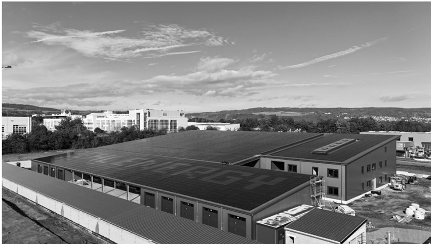
Rehl Energy 4 Ladepunkte a 320kW 14 Ladepunkte a 22kW
