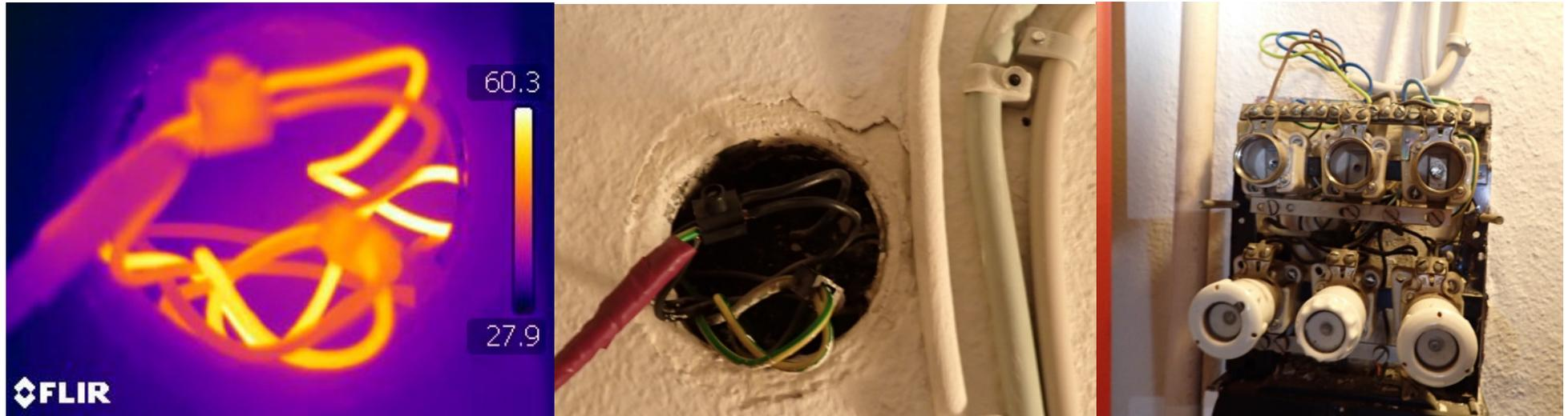
Elektroinstallation aus 60iger Jahren, Schraubsicherungen, Kupferleitungen
