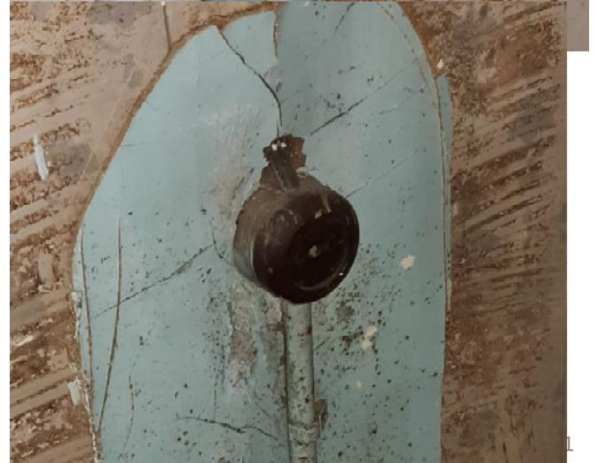
Aluminiumleitungen Aufputz, Gummiisolierung
