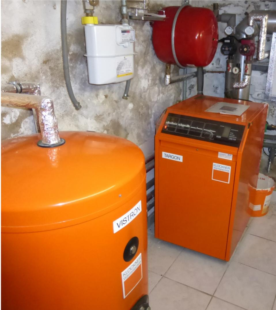
Gaskessel mit atmosphärischem Brenner und WW-Boiler
