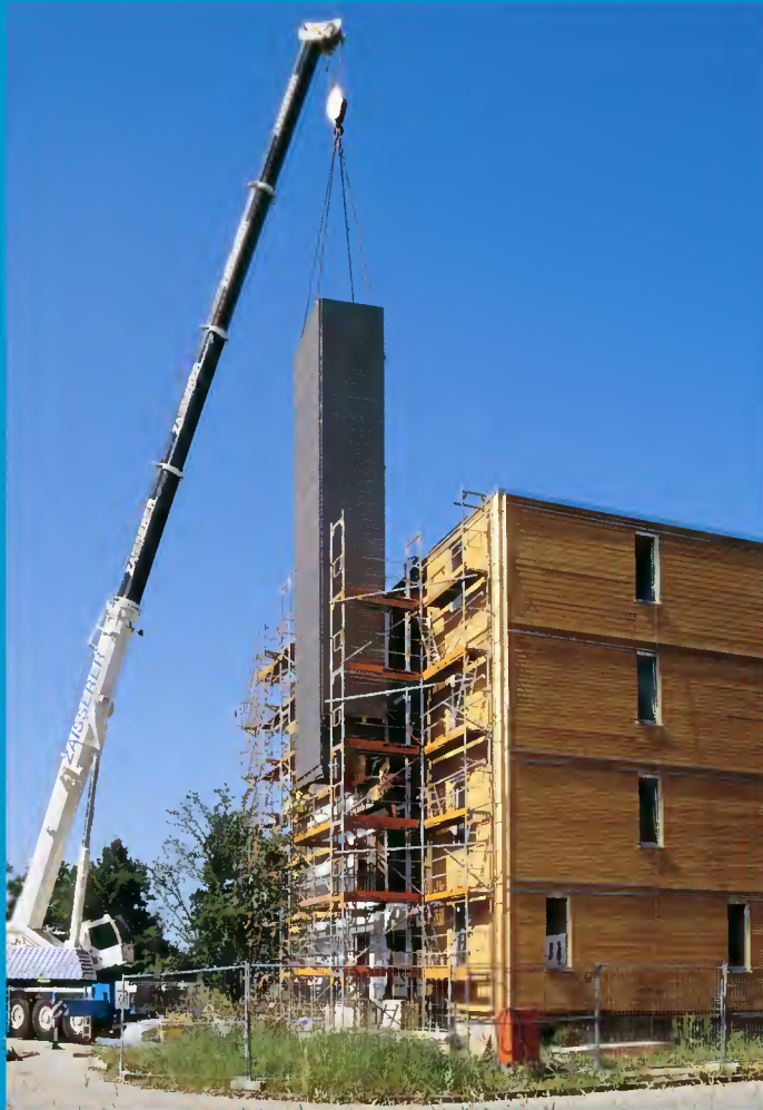
Montage Aufzugsschacht
