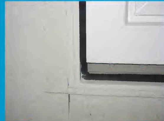
Gekapselte Leibung mit versetzten Stoßfugen
