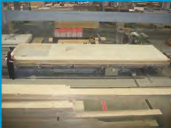
Herstellung von großflächigen Wandelementen
