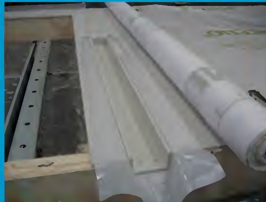
Einbau eines gekapselten Installationskanales
