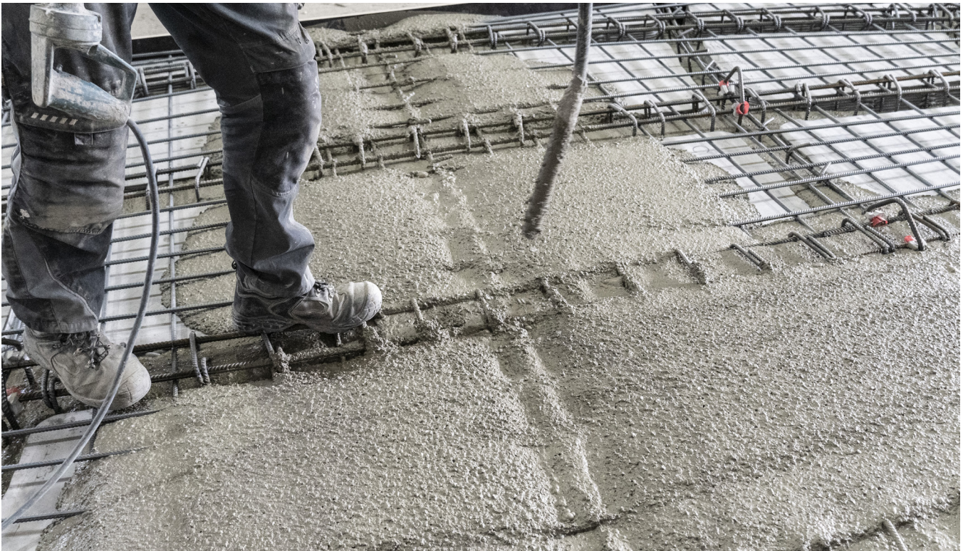
Einbringen des Betons
