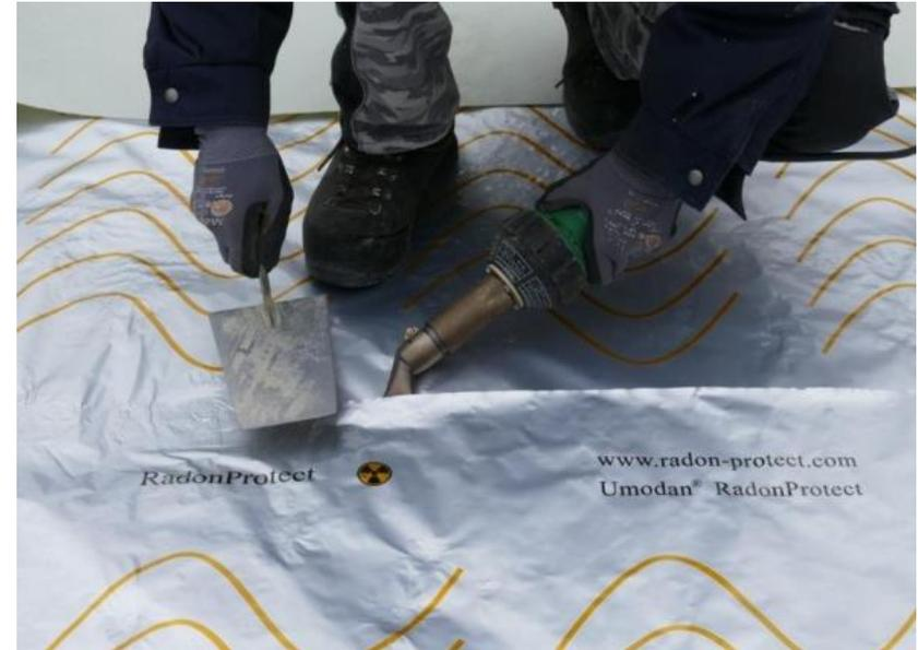
Folienbahnen mit Heißluft radondicht
