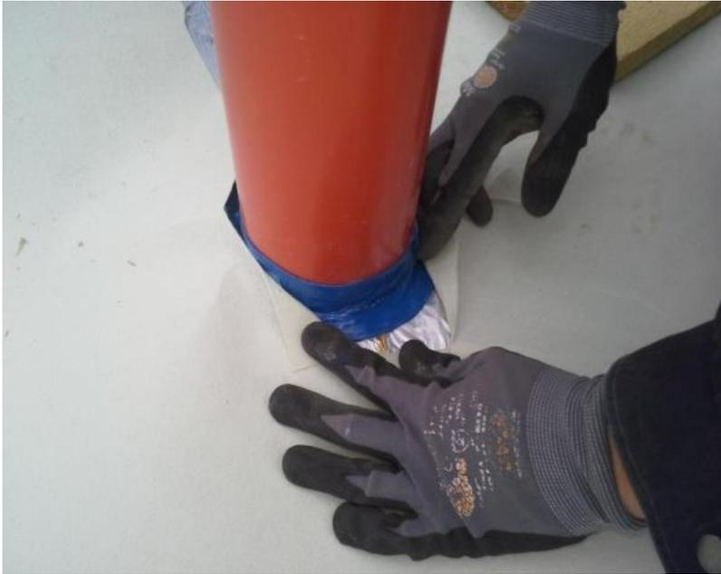
Gasdichter Anschluss an eine Durchdringung, Abdeckung der RadonProtect Folie mit Wikaflor Schutzvlies
