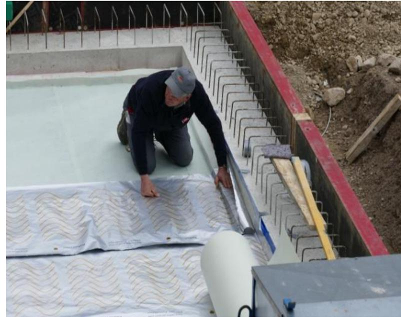
Gasdichter Anschluss an Betonteile
