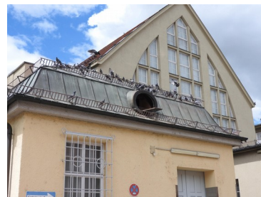
Taubenhaus in Dachstuhl
