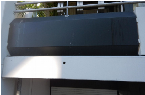
Balkon mit eingebautem Nistplatz
