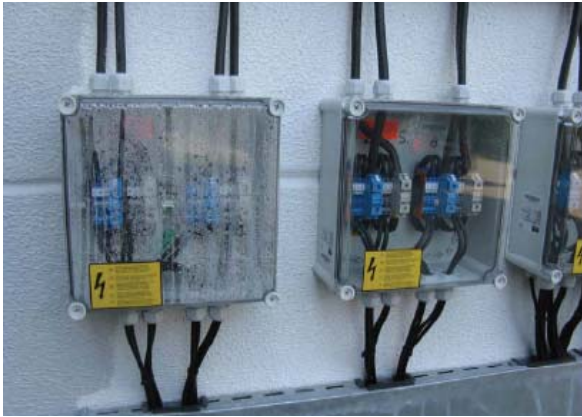
Bild 15: Kondenswasserbildung im Stringkasten (Quelle Markus Scholand)
