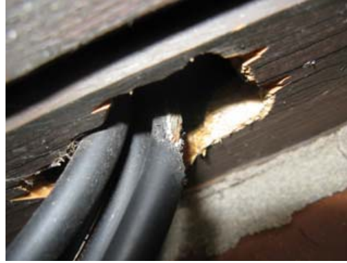
Bild 10 und 11: Beschädigungen von Leitungen (Quelle Markus Scholand)
