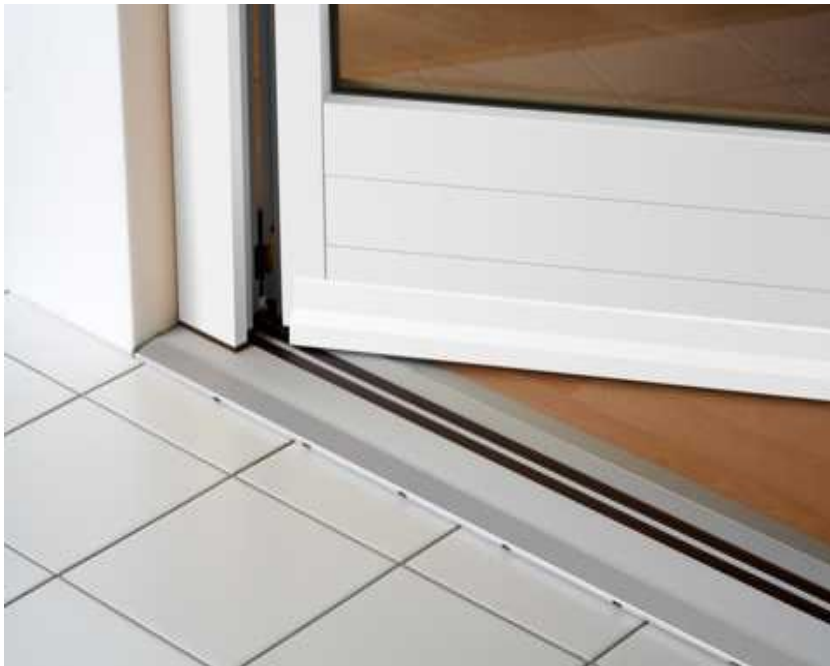
Magnet- Doppeldichtung
