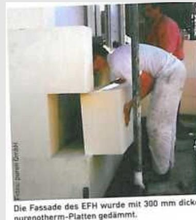
Die Fassade des EFH wurde mit 300 mm dicken purenotherm-Platten gedämmt.
