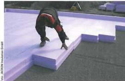
Perimeterdämmung auf Basis von JACKÖDUR® KF mit dem Schalungssystem JACKÖDUR® Atlas.
