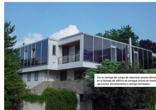
Energetische Sanierung eines Flachdach-Bungalows BJ 1964 – Die Solarthermie-Fassadenanlage versorgt neben der Warmwasserleitung und solaren Heizungsunterstützung auch die Sole-Wasser-Wärmepumpe zur Nacherwärmung.
