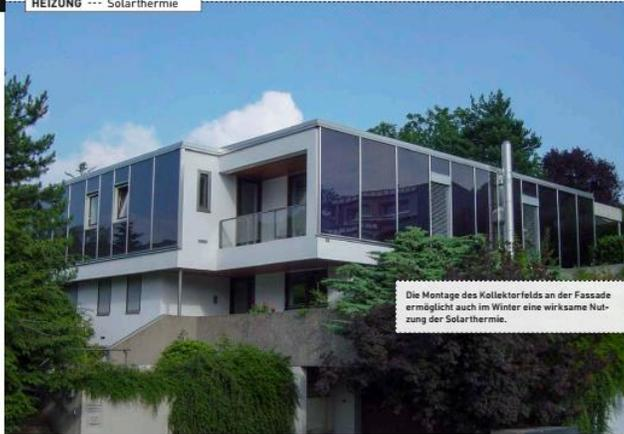
Die Montage des Kollektorfelds an der Fassade ermöglicht auch im Winter eine wirksame Nutzung der Solarthermie.
