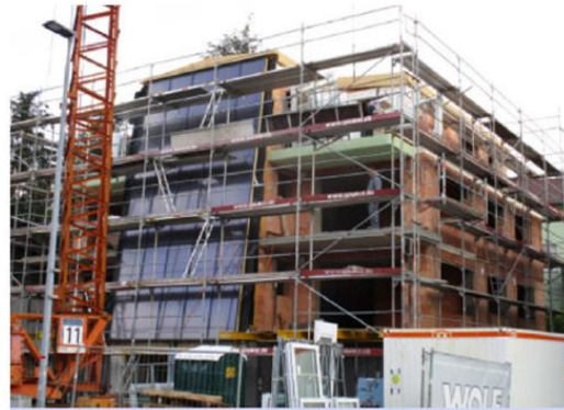
einschaliges Mauerwerk Poroton T9 36,5cm KfW-Effizienzhaus 55 - Standard
