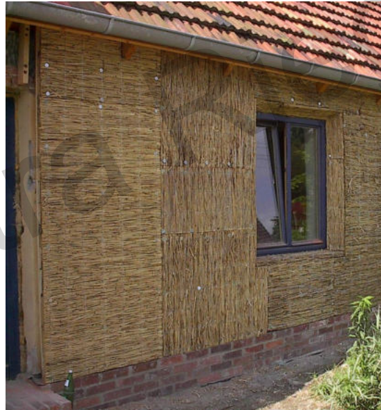
Wandaufbau 4: Fachwerkwand mit Außendämmung
