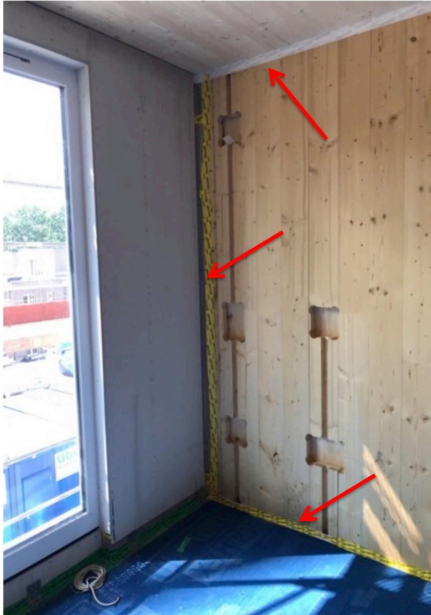
**Wird durch verklebte Bauteile oder durch Beplankungen sicher gestellt.**
