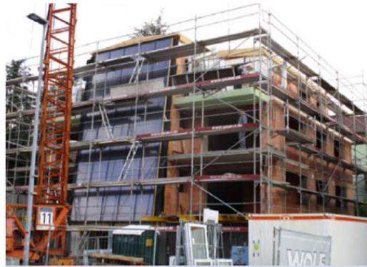
einschaliges Mauerwerk Poroton T9 36,5cm KfW-Effizienzhaus 55 - Standard
