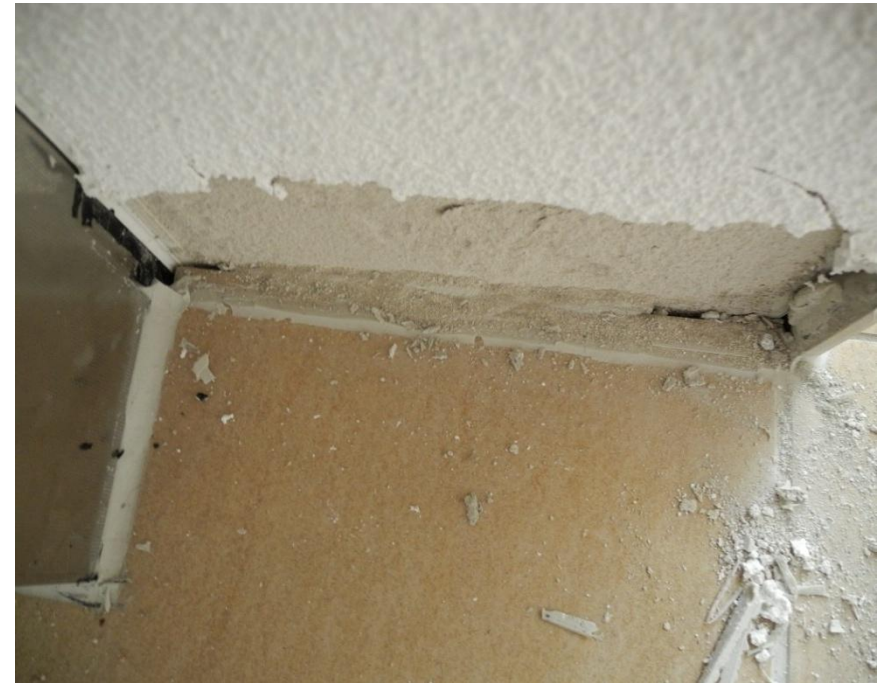
Öffnung Anschlussfuge unter Sockelleiste
