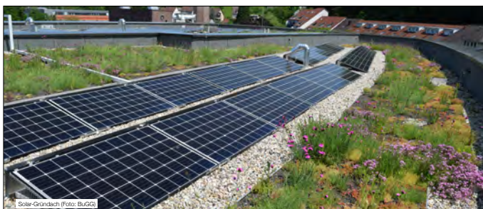
Flachkollektoren – flächenanteilige Nutzung, monofunktional aufliegend, geringer Windangriff klare Gewerkerennung (Pflege/Wartung) Extensiv- und Intensivbegrünung möglich
