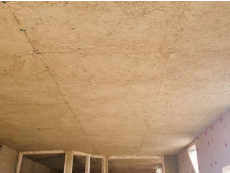
UNTERSICHT ABHANGDECKE MIT GES- CHLÄMPTEN HOLZWEICHFASER-AUSBAU- PLATTEN
