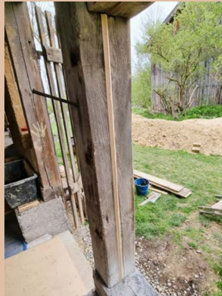
DREIECKSLEISTEN SEITLICH MONTIEREN. DIESE WERDEN MIT EINGEPUTZT
