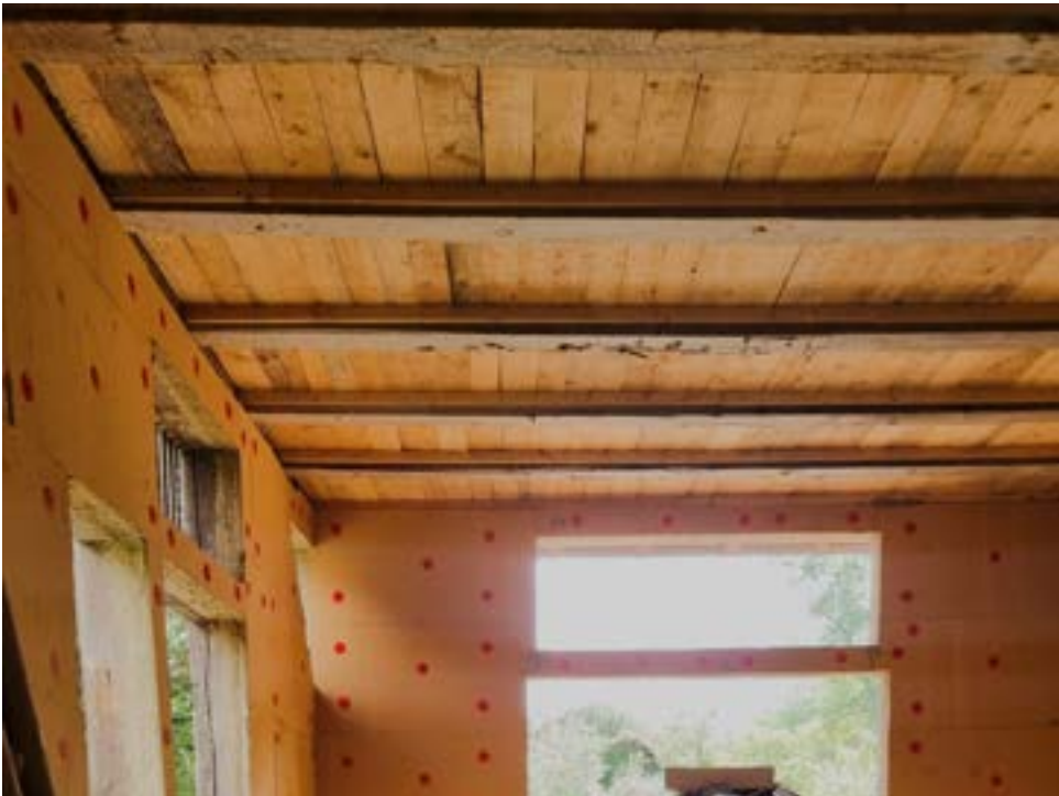
DECKE MIT EINGEBAUTEN FEHLBÖDEN
