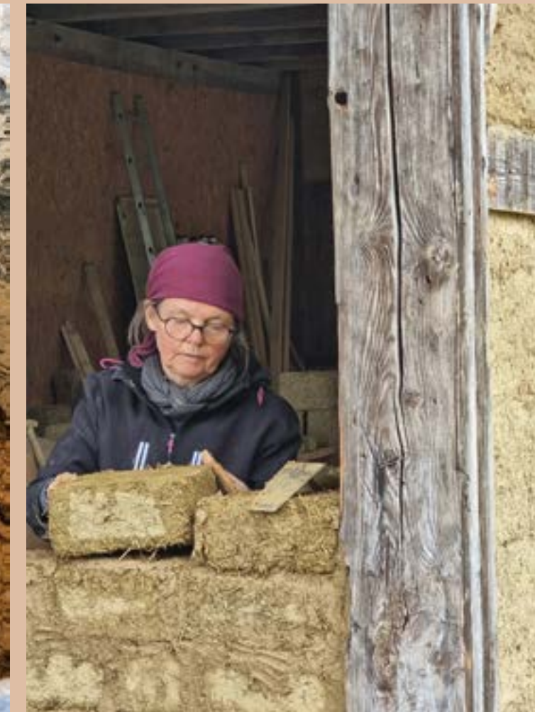
MAUERARBEITEN MIT LAGER UND STOSSFUGENVERMÖRTELUNG
