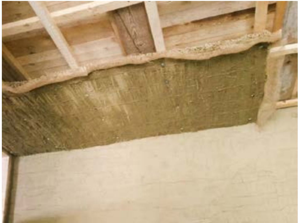
DECKE MIT MONTIERTER SCHIL- FROHR-LEICHTBAUPLATTE, EINGESCHLÄMMT UND VLIES ALS ARMIERUNG DER STOßFUGEN
