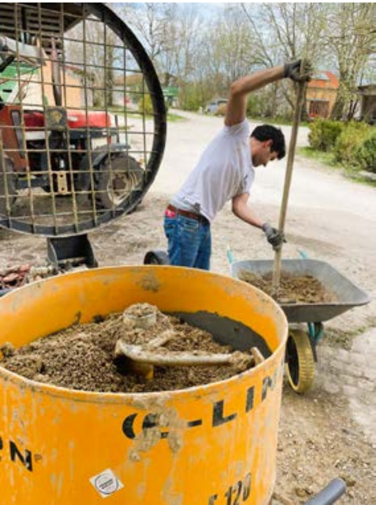
MISCHEN DER SCHWEREN SCHÜT- TUNG AUS NATURLEHM UND SPLITT
