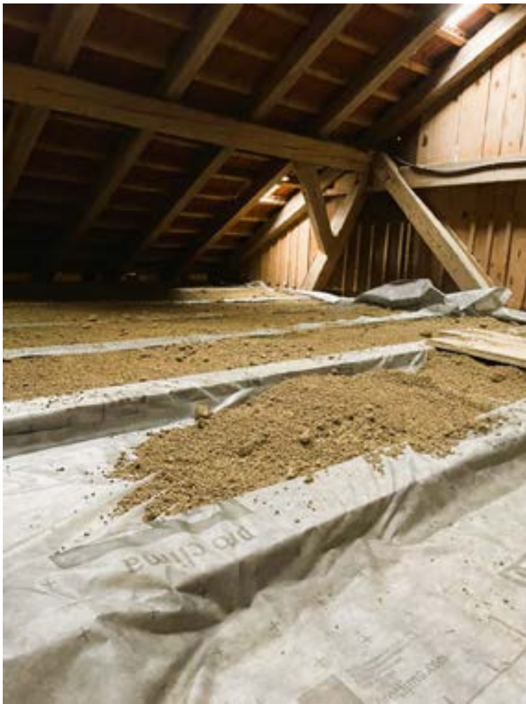
GEOTEXTIL UND EINBRINGEN DER LEHMSCHÜTTUNG
