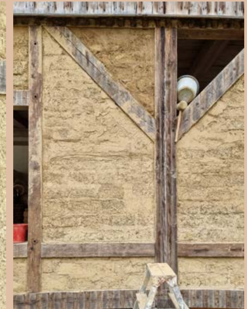
FERTIGGESTELLTS LEHM-STEINMAUERWERK
