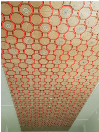
HochLeistungsLehm-Module verlegt mit eingelegtem Kühlrohr. https://argillatherm.de/
