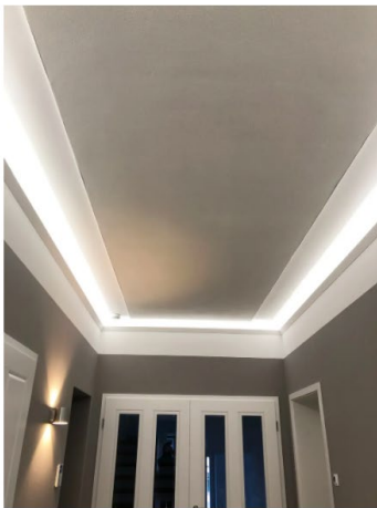
HochLeistungsLehm-Module verlegt mit eingelegtem Kühlrohr nach Fertigstellung.
