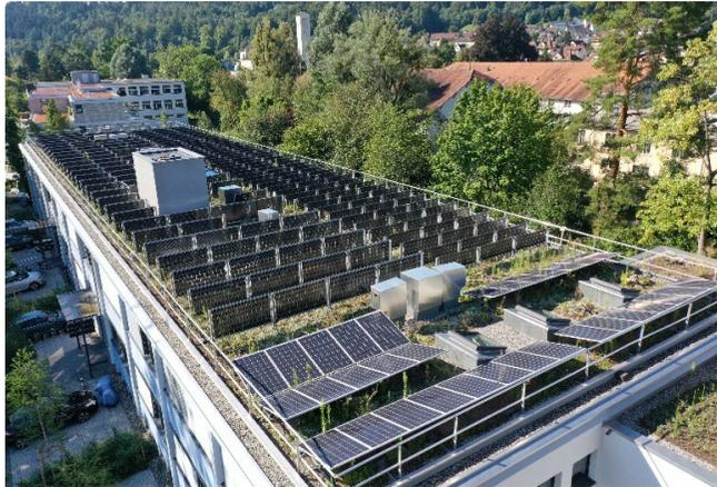
Unterschiedliche Aufgeständerte PV-Module
