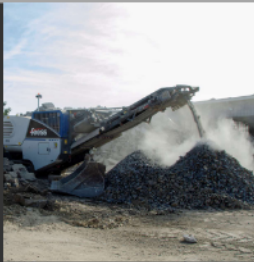
Recycling Brechen & Sieben
