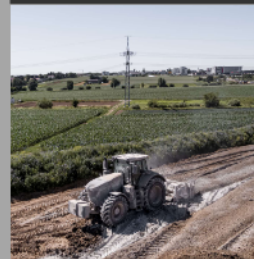
Boden- stabilisier- ung
