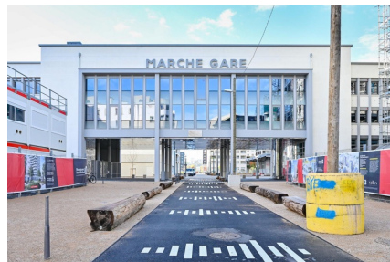
Gebäude A (35 kWp PV Anlage)
