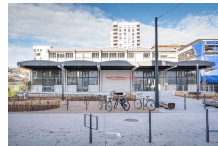
Gebäude B (ohne PV Anlage)
