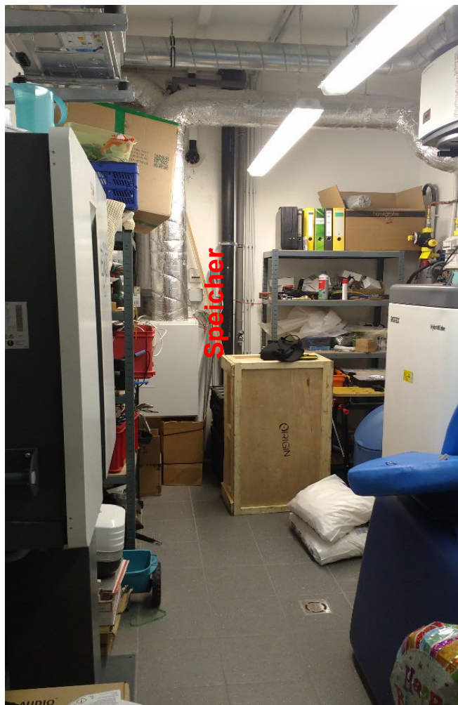
Heiz- und Abstellraum
