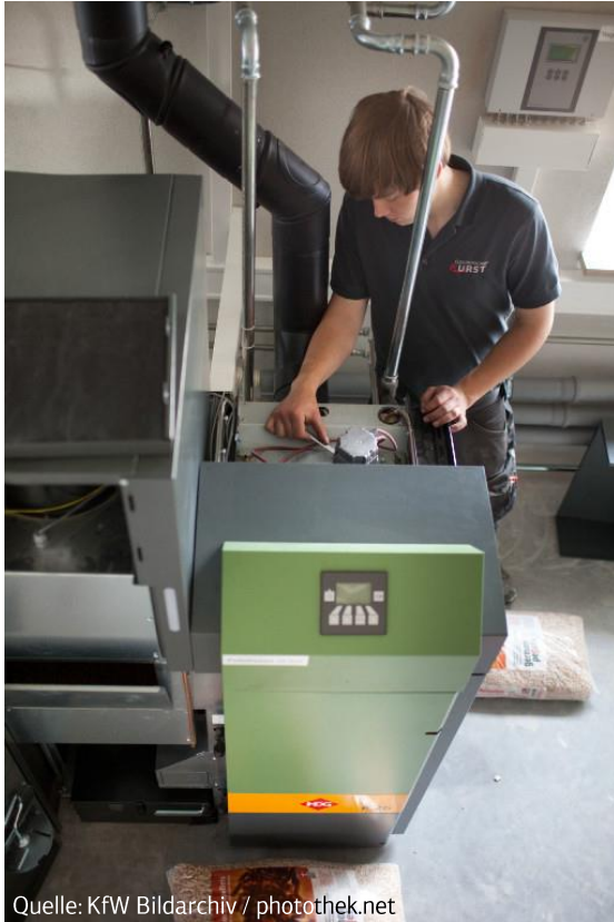
Quelle: KfW Bildarchiv / photothek.net Abb. Montage einer Holzpelletsheizung
