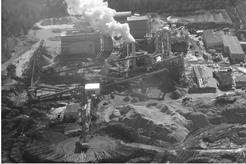
Biomassekraftwerk im Südosten der USA (RobinWood.de)
