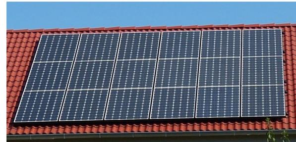
*3 PV-Module im Standardformat 1,65 m x 1 m haben ca. 1 kW<sub>peak</sub> Leistung*
