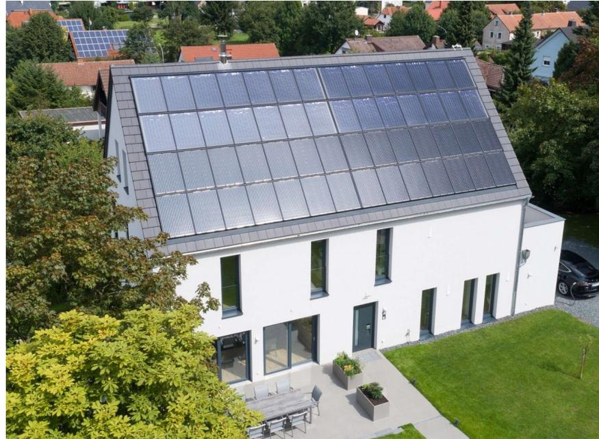
Solarthermie (oben) und Photovoltaik (unten) kombiniert für die beste Nutzung von Sonnenenergie
