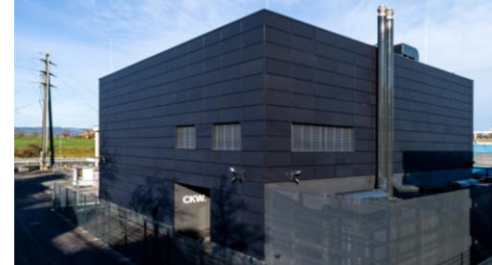
CKW Rechenzentrum Schweiz, Q4/22
