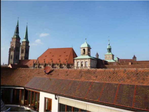
Bild 1: PV-Anlage auf dem Neuen Rathaus, Hauptmarkt 18
