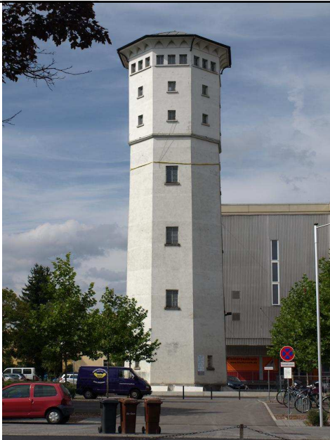
Radolfzell, Wasserturm des ehem. Milchwerks , Foto 2010
