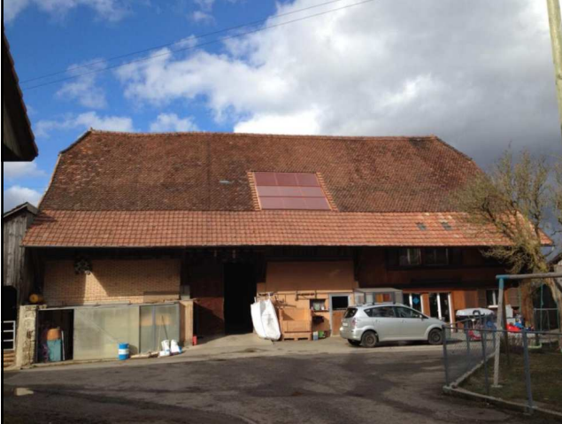
Quelle: Figur 2: Testinstallation von neun a-Si Modulen zur Verifizierung von Farbe, Glastextur und Format / Schlussbericht Seite 9
