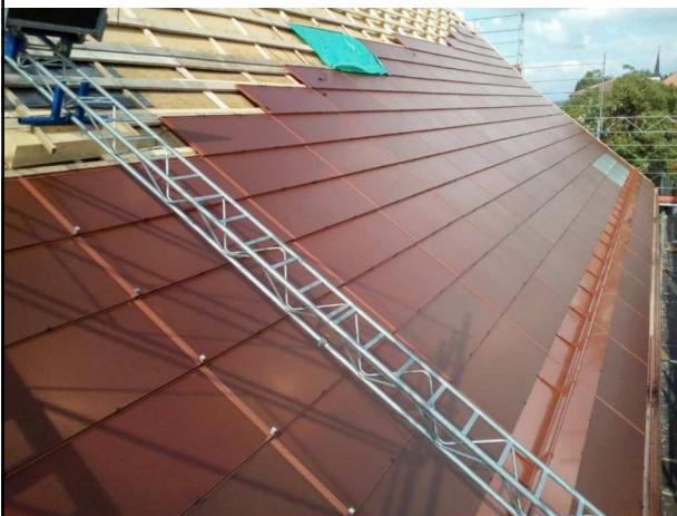
Figur 14: Situation während der Eindeckung im August 2017
