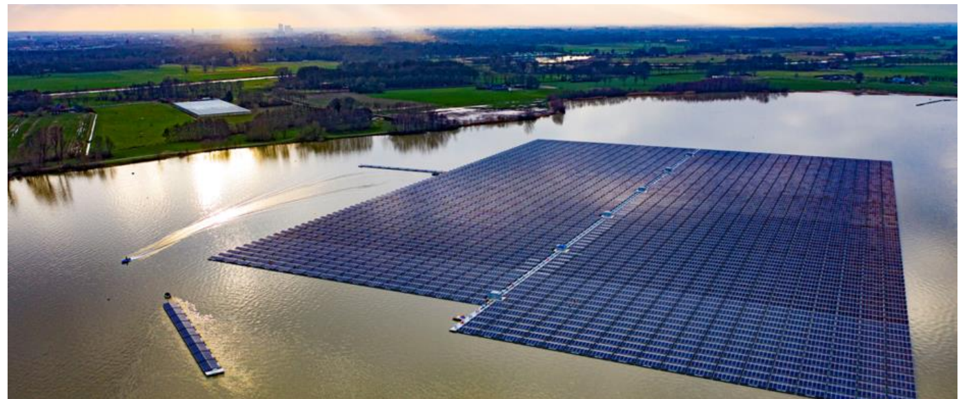
Größtes Floating PV System außerhalb von China
