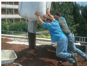
Aufbringen des Substrats auf die vorbereitete Dachfläche
