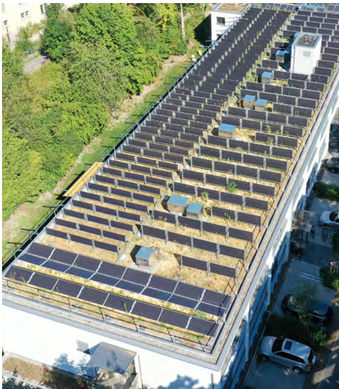
Abbildung 7: PV-Anlagen mit senkrecht/bifazialen PV-Modulen sowie in einem kleinen Bereich PV-Module in Schmetterlingsform aufgeständert. (Quelle: Zinco)
