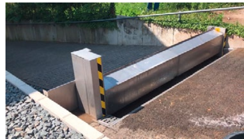
Abbildung 7 Mobiles Klappschott (Anhamm GmbH ( www.klappschott.de ))
