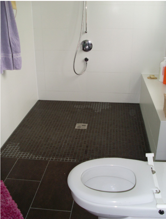
Abbildung 12: Bodengleiche Dusche, rollstuhlgerecht, farblich kontrastierend
