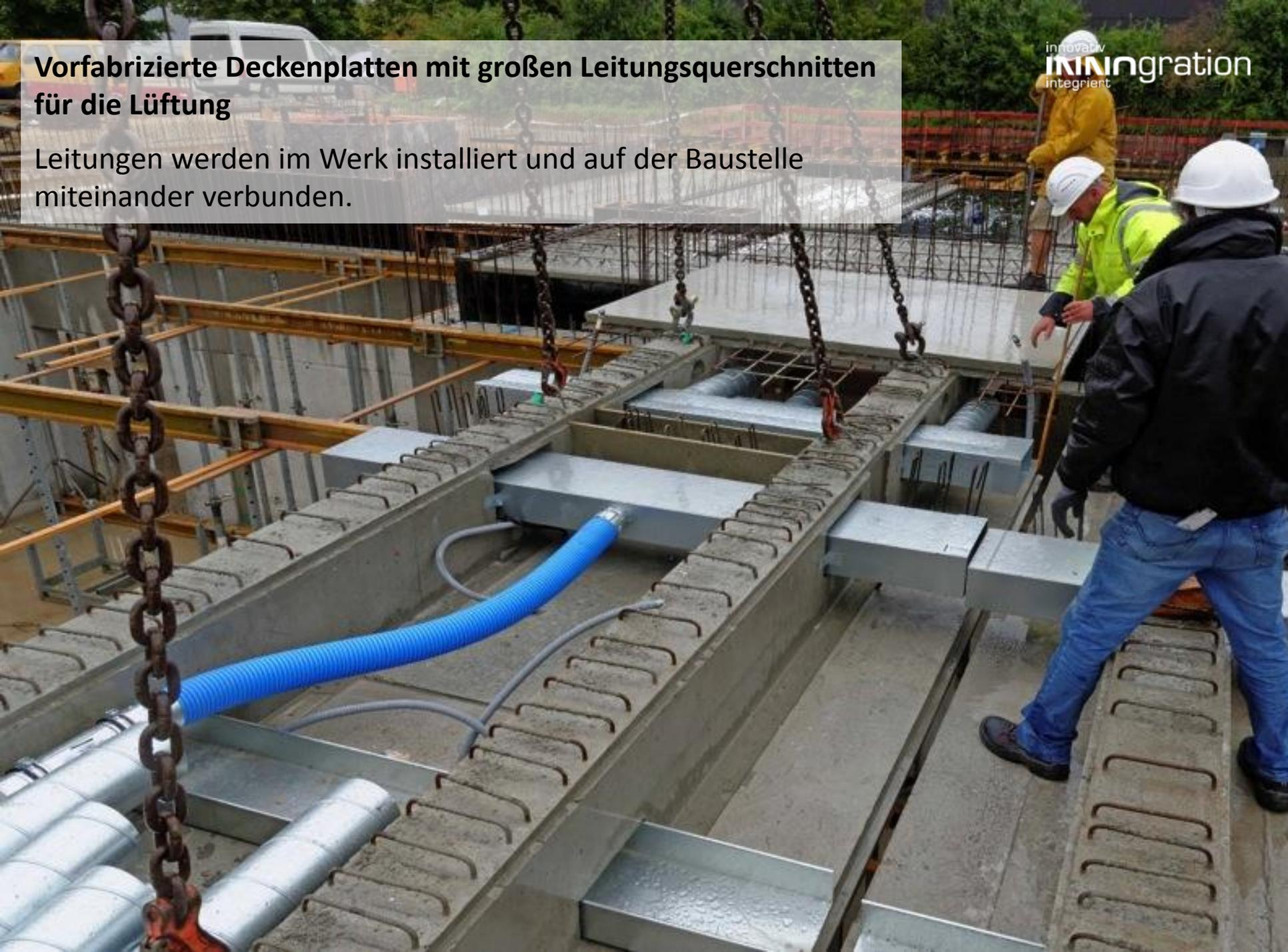
**Der Deckenhohlraum zwischen den tragenden Rippen wird für die Installationen der Haustechnik Leitungen genutzt**
