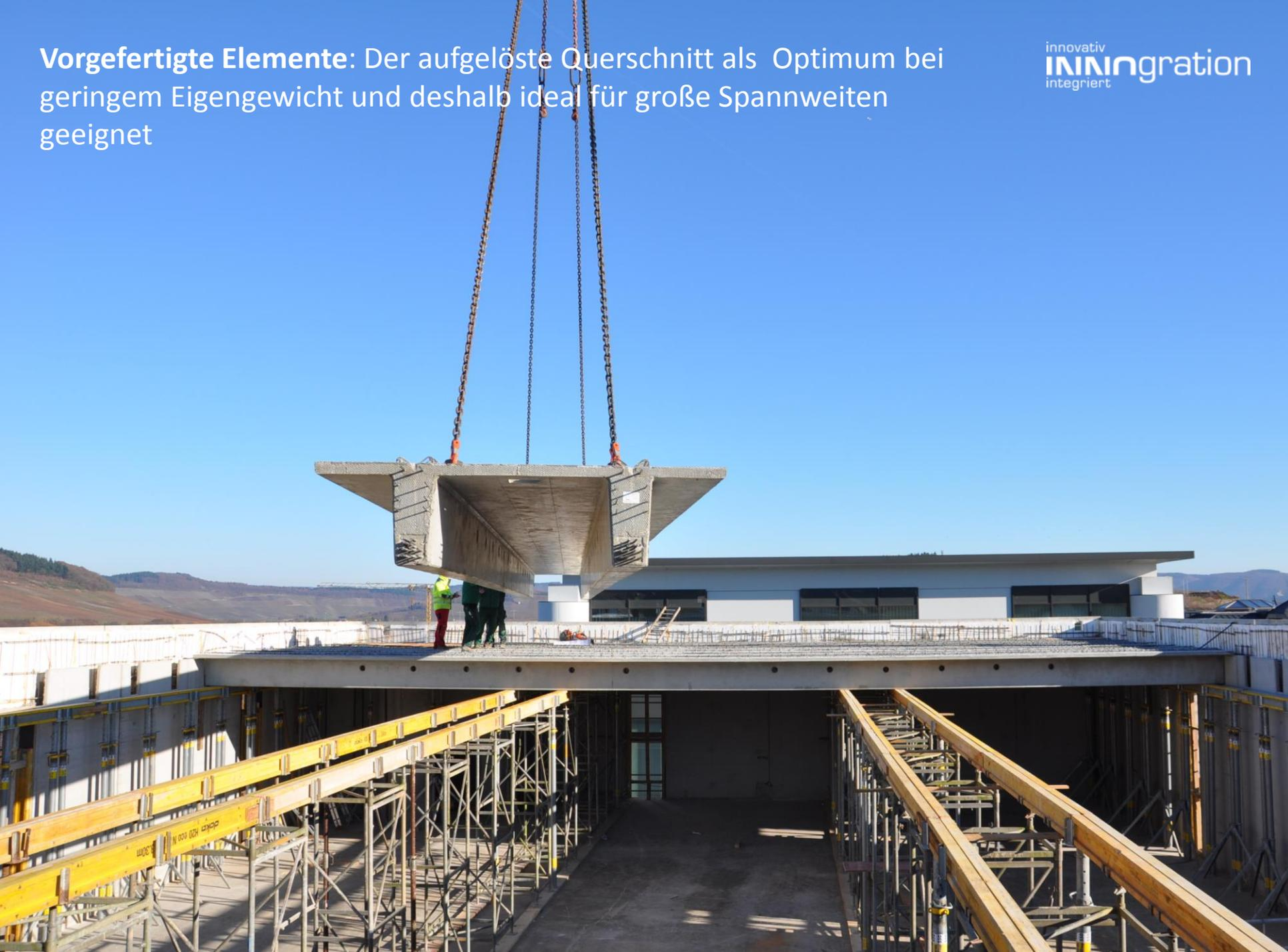
Vorgefertigte Elemente: tragende Bauteile meist mit Vorspannung
