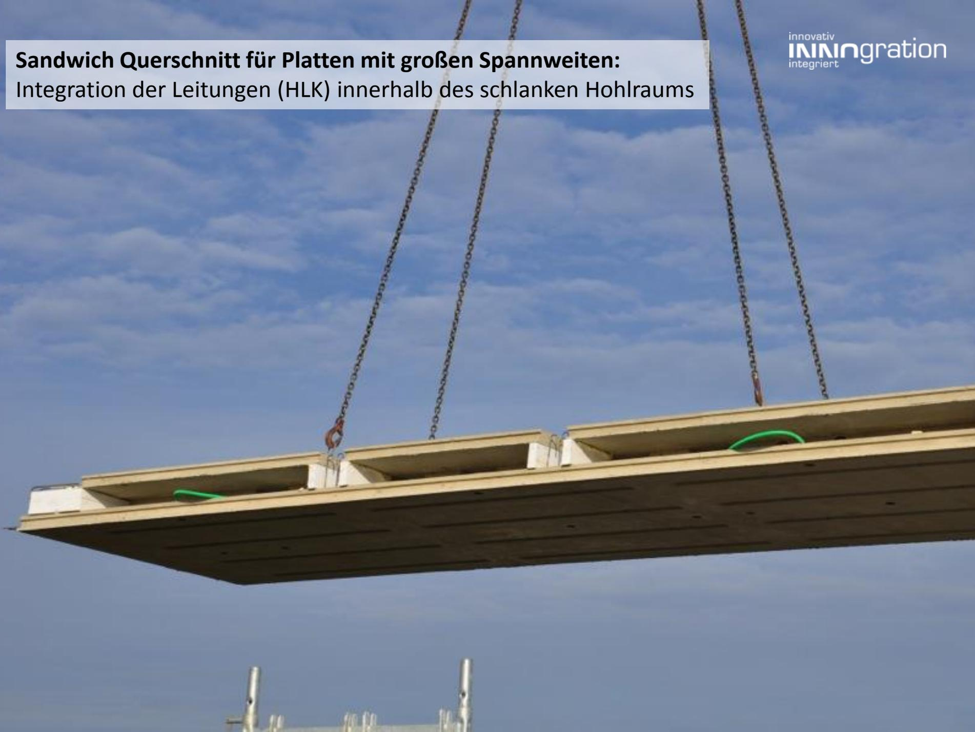
**Tragendes Bauteil in der Kombination mit weiteren Einbauteilen
