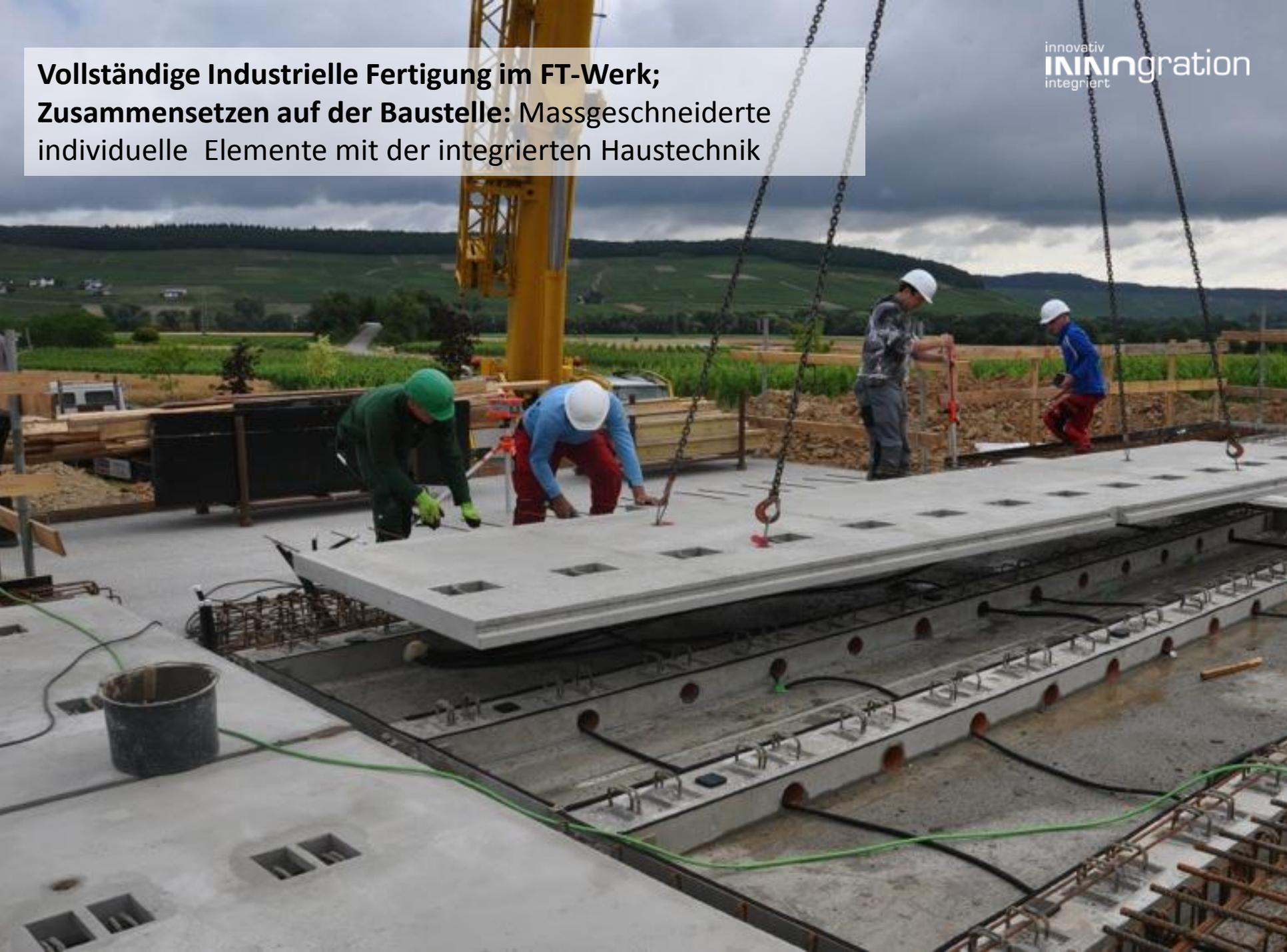
**In der Übersicht - alle Aktivitäten auf der Baustelle: Versetzen der unteren Platte; Ergänzungen der Haustechnik Leitungen; Versetzen der oberen Platte zur Formung des Querschnitts**
