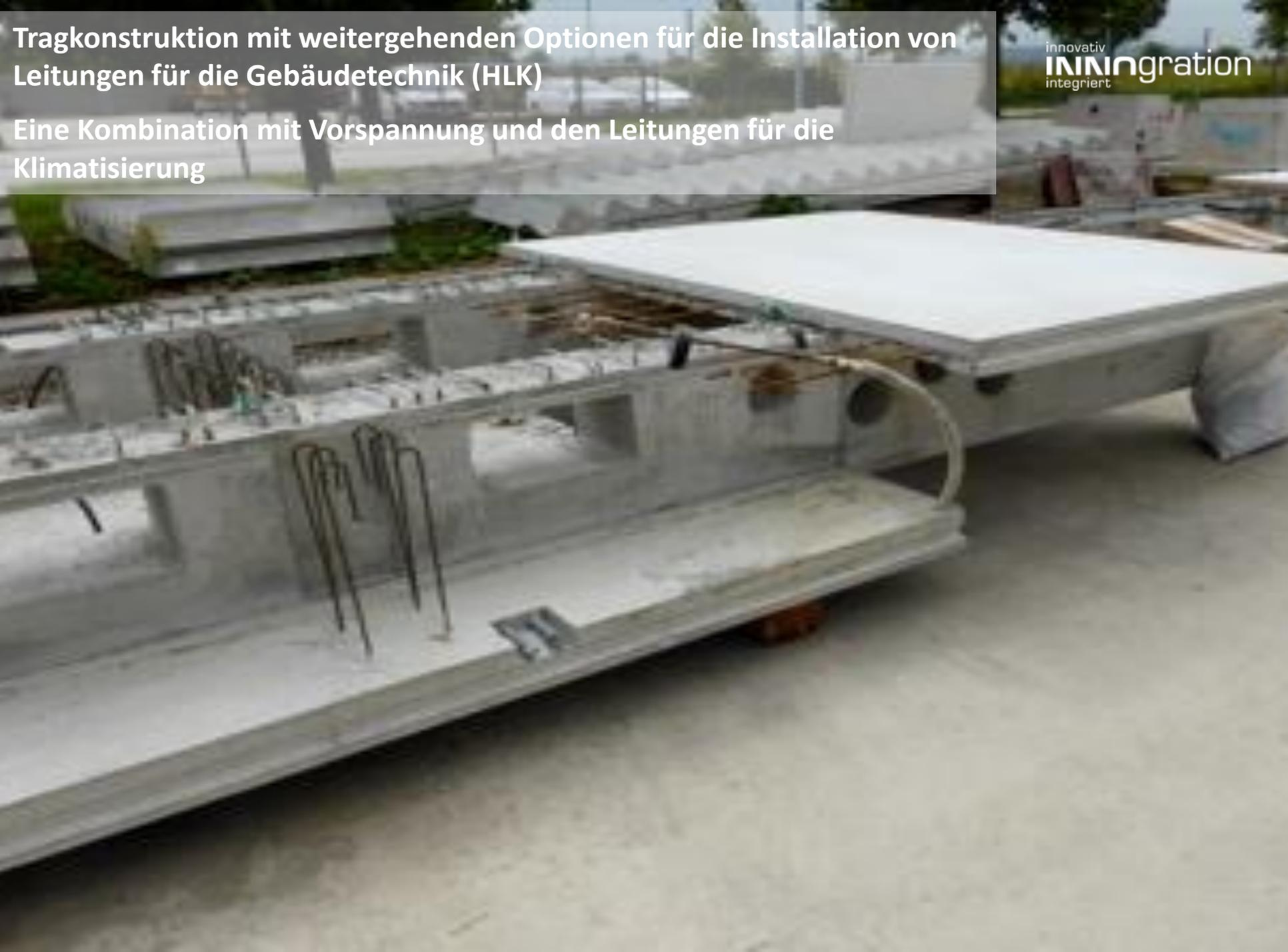
**Vorgefertigte Elemente:** mehr als ein tragendes Element –
