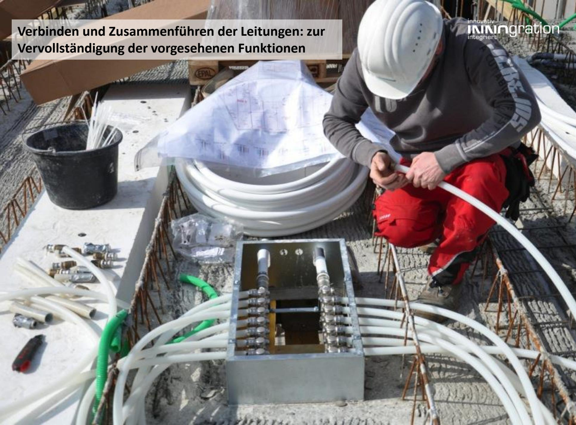
Der Deckenhohlraum zwischen den tragenden Rippen wird bspw. für die Anordnung von vorgefertigten Verteilern genutzt, um optimal zonenweise entweder Heizen oder Kühlen zu können
