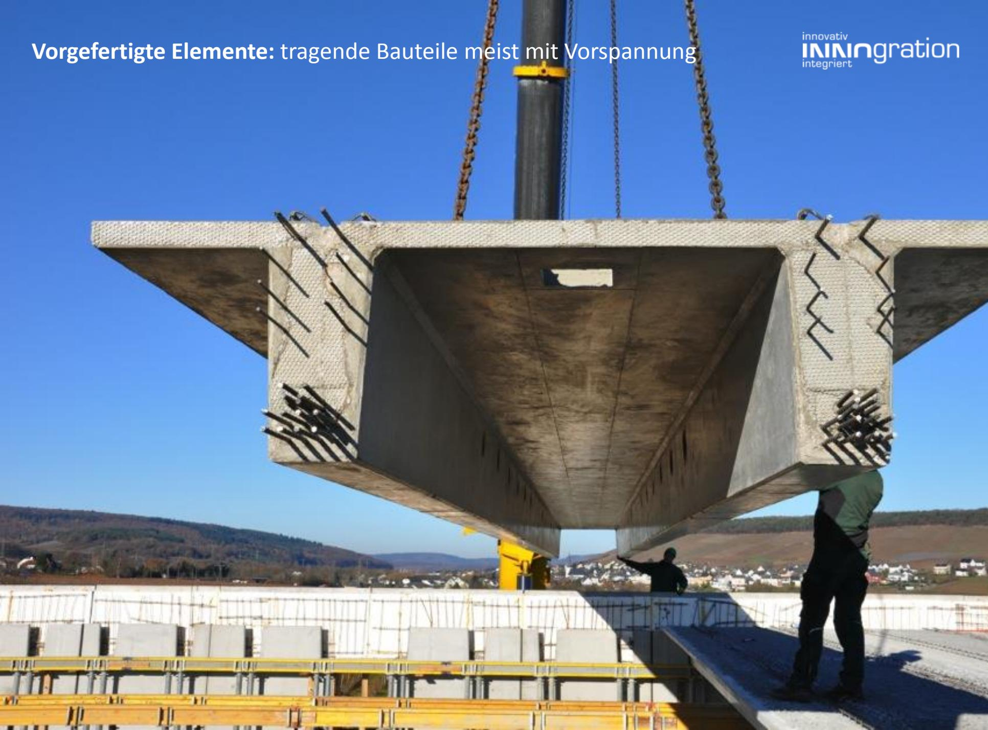
**Vorgefertigte Elemente:** tragende Bauteile lassen sich noch mehr nutzen wie z.B. mit weiteren Funktionen wie Heizen und Kühlen Energie Effizienz lässt sich mit der Bauteilaktivierung erzielen.
