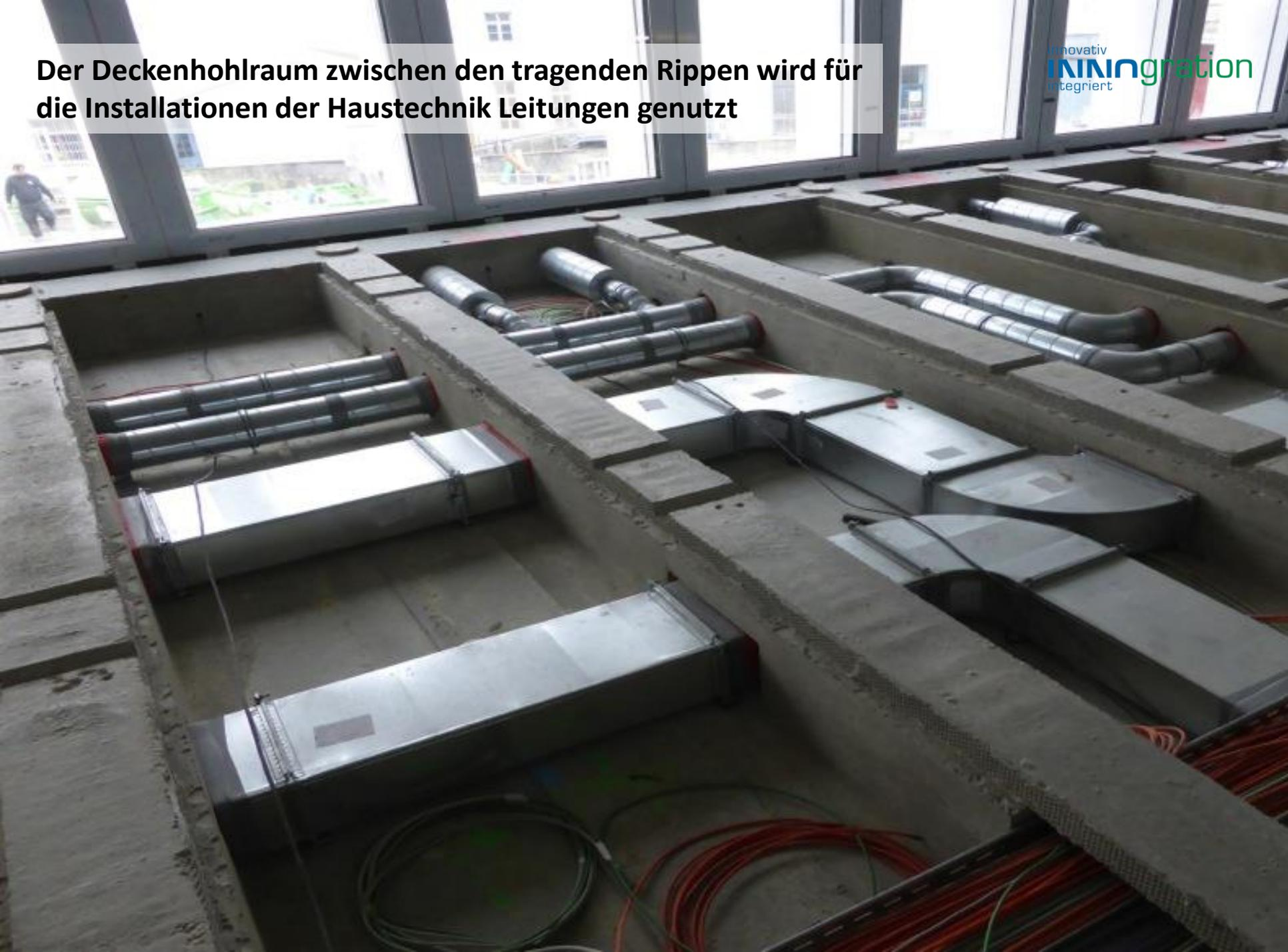
**Deckenhohlraum und große Öffnungen in den tragenden Rippen für die Leitungsführung der Haustechnik**
