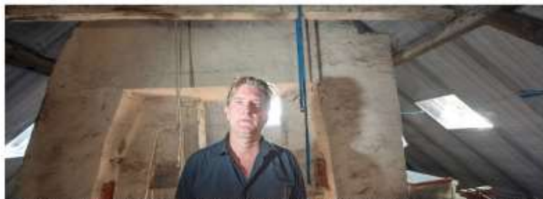
Es riecht heftig unterm Dach nach der Sanierung. Nicht nur Edgar Jablonski hat Angst um die Gesundheit. Foto: Ingo Otto
