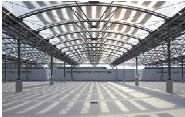
Carportdach des AWM
