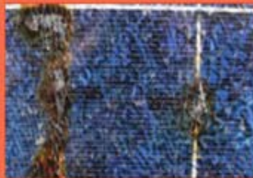
Schmorstellen auf der Frontseite
