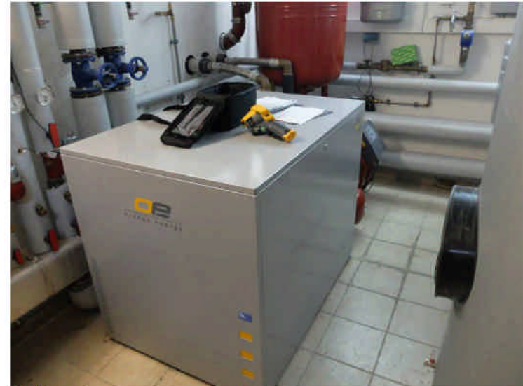
Bild 3 Grundwasserwärmepumpe, Fabr. Orange Energy, Heizleistung 103 kW bei W10/W35
