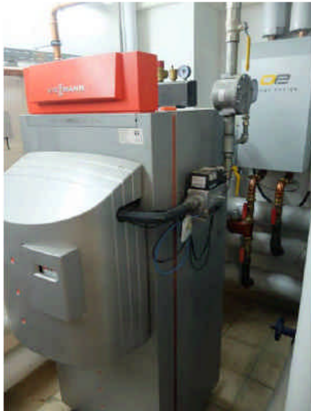
Bild 1 Gasbrennwertheizkessel, Fabr. Viessmann, Heizleistung 45 bis 134 kW
