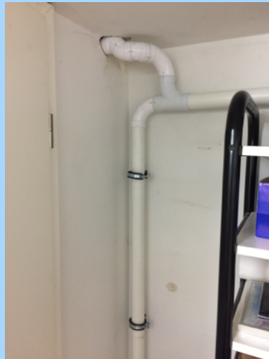
2017 Neue Abzweigung zu Absaugpunkt 2
