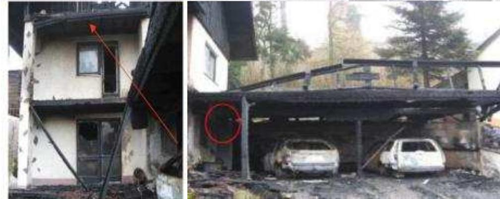
Das Feuer griff über den hölzernen Carport auf die Balkone, die Holzfassadenverkleidung und den Dachstuhl und brannte im Dachgeschoss bis zum gegenüberliegenden Giebel durch.
