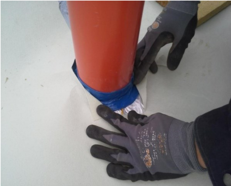
Gasdichter Anschluss an eine Durchdringung, Abdeckung der RadonProtect Folie mit Wikaflor Schutzvlies
