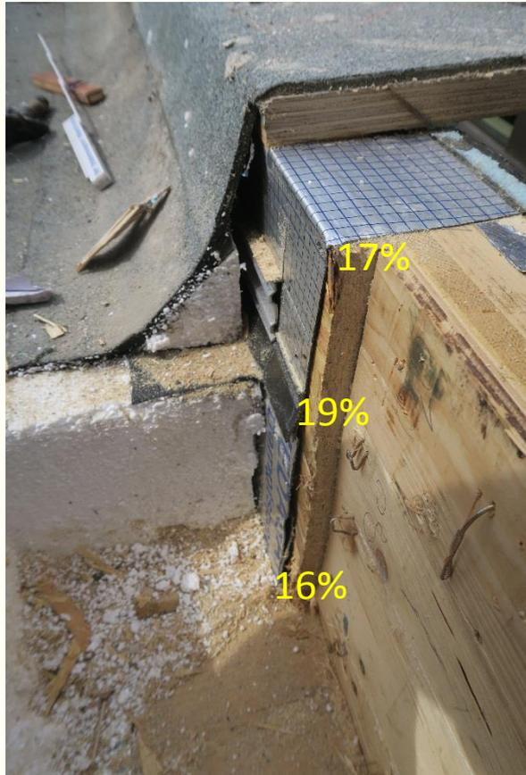
Die Dampfbremse wurde vom warmen Bereich in den kalten Bereich geführt. Warme Luft kann sich unter der Dampfbremse ausbreiten und führt durch Kondensation zu einer Feuchtigkeitsanreicherung im Übergang vom warmen zum kalten Bereich.
