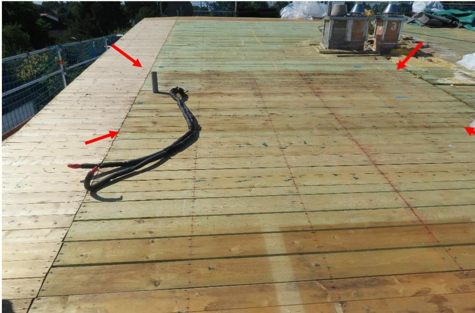
Die Solaranlage hat das Blechdach verschattet. Das Holz ist unter der Solaranlage deutlich feucht, so dass sich der Schattenwurf abzeichnet.
