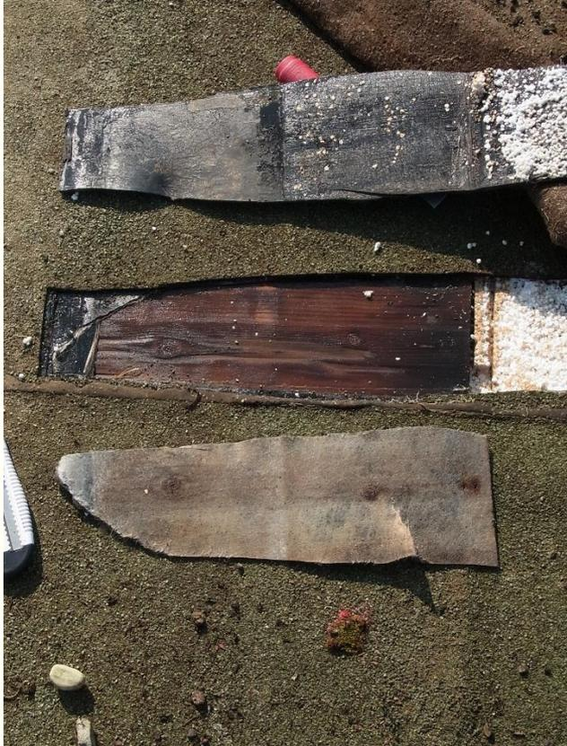
Eine Wasserkonzentration unter der Dachabdichtung findet in jedem Dach statt. Durch Rücktrocknung durch die Dachbahn oder durch die Dampfbremse wird die Wassermenge im Sommer reduziert.
