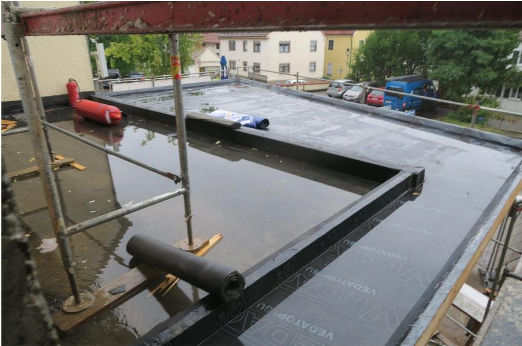
Wannenausbildung durch Hochzug der Dampfbremse bzw. des Unterdaches muss vermieden werden. Ins Dach eindringendes Wasser muss ablaufen können.
