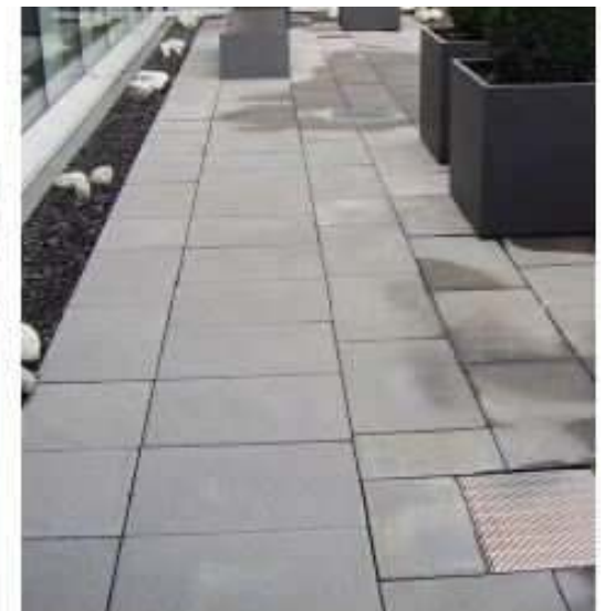
ACO Profile im Verbau mit Stichkanal unter dem Plattenbelag
