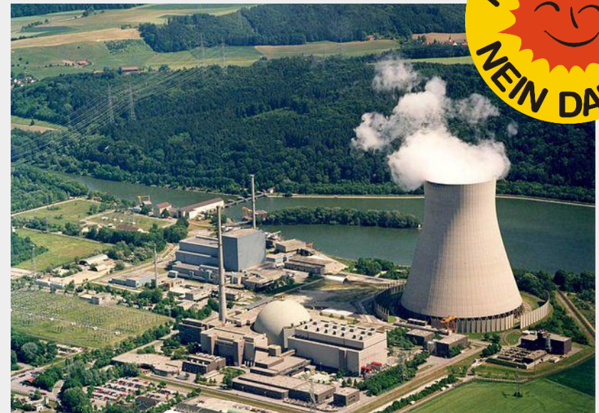
Kernkraftwerk Isar (bei Landshut)
