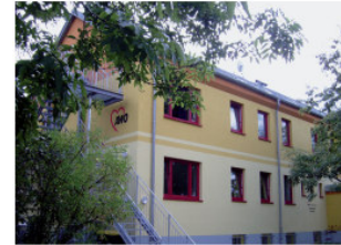
Diese Kindertagesstätte wurde 2009 energetisch saniert. Dabei wurde eine Aereco bedarfsgeführte Abluftanlage eingesetzt.
