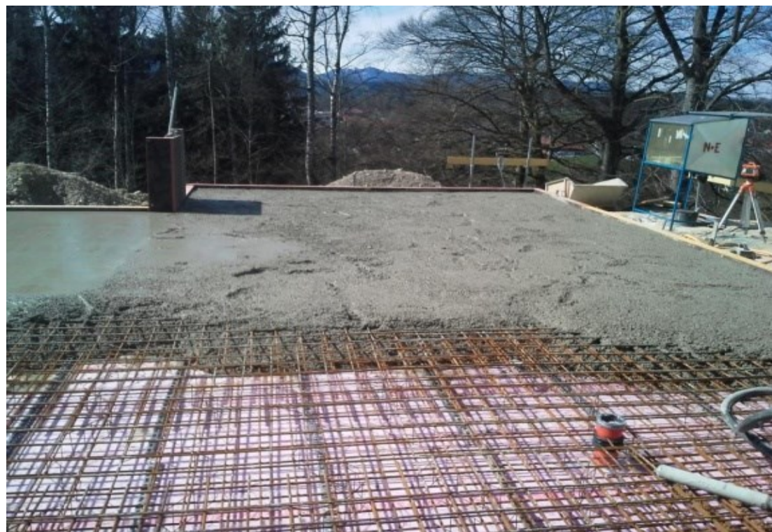
Weiterer Aufbau mit Dämmung und gegossener Bodenplatte
