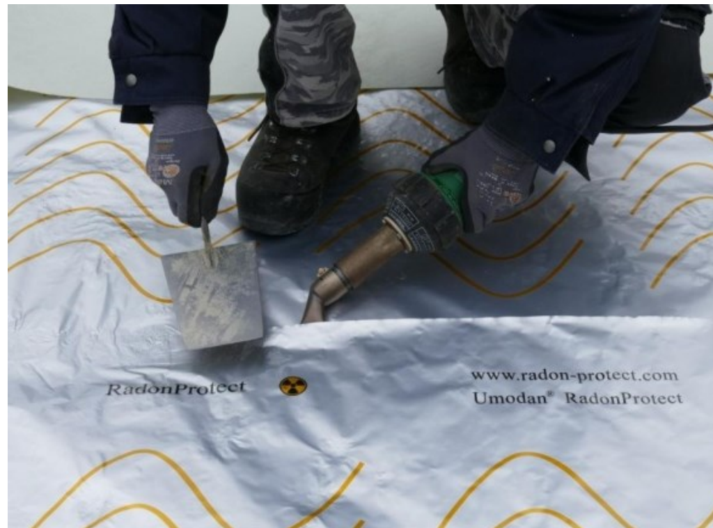
Folienbahnen mit Heißluft radondicht verschweißen
