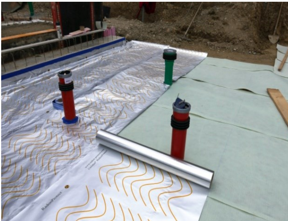
Umodan® RadonProtect Folie auf Wikafloor Schutzvlies auslegen
