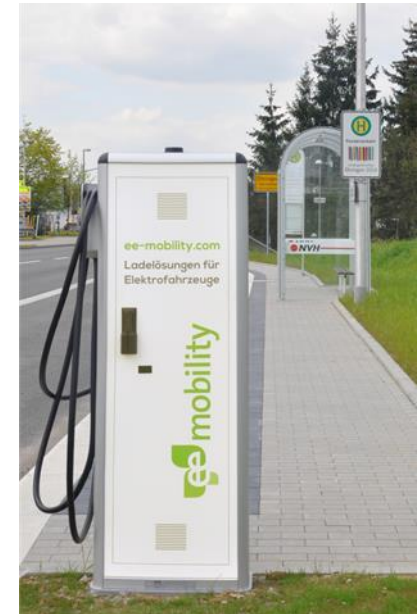
Ladestation für Elektrobuss
