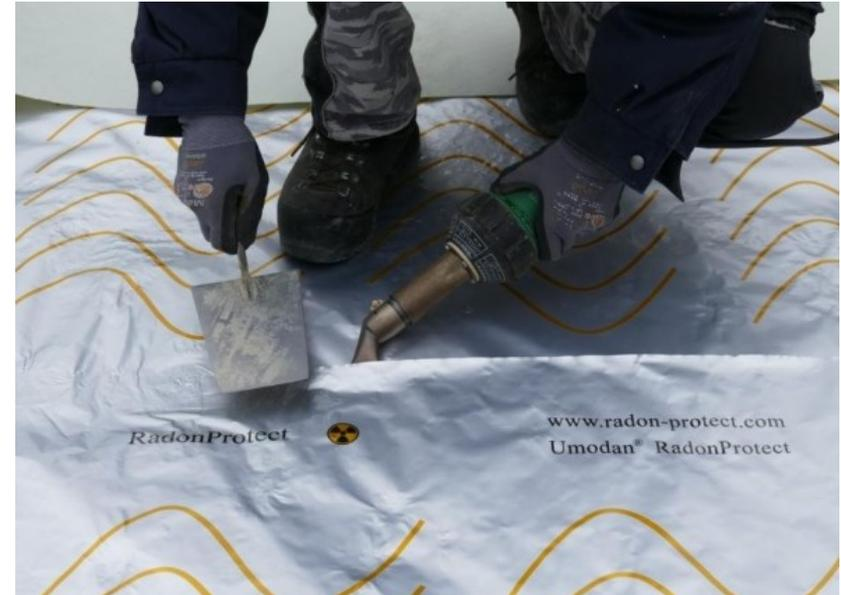
Folienbahnen mit Heißluft radondicht
