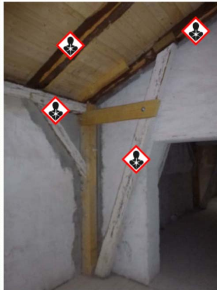
Foto mit Darstellung Bestands- und neuer Konstruktionshölzer im Dachraum (beispielhaft)
