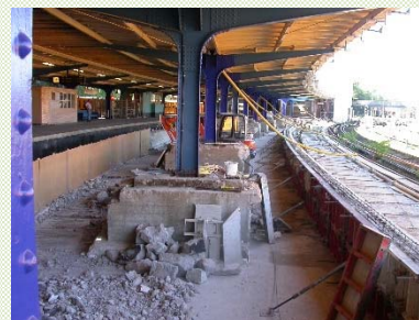
schwermetallhaltige Anstrichstoffe (Blei, PCB)
